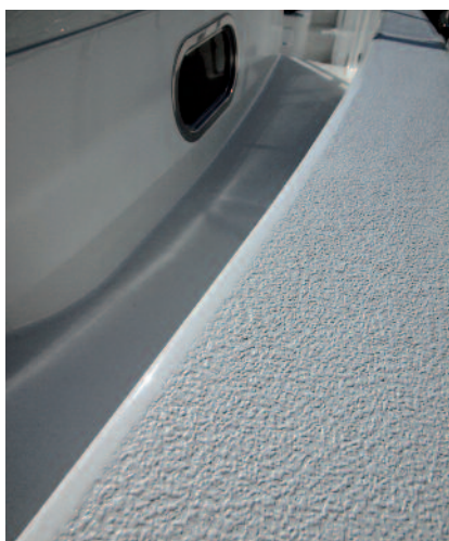
Rutschhemmende Struktur auf dem Schandeck.
